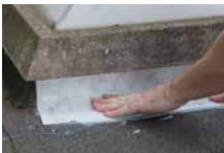
Poussez le DryStone Textile dans une deuxième fine couche
