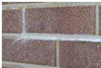
Lisser avec un fer à joint (humide)
