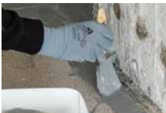
Appliquez jusqu'à +/- 5 cm sur le sol
