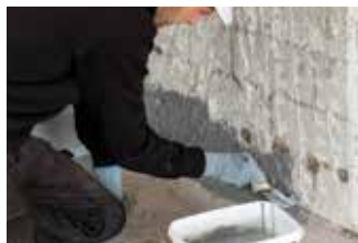
Travaillez jusqu'à +/- 5 cm au-dessus des trous de forage
