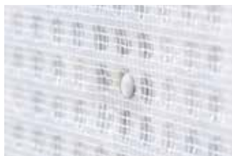
Toujours tendre la membrane entre 2 chevilles
