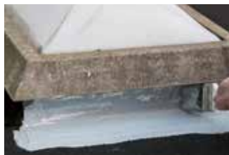
Appliquez une dernière couche épaisse avec un minimum de 4 cm autour du textile
