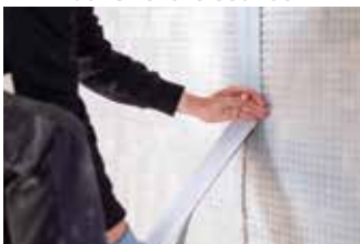
Placez le DryStone Tape sur les raccords, aux angles, sur les dommages, autour des boîtiers encastrés, tuyauteries, ...
