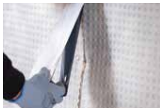
Raccordez les bandes côte à côte sans chevauchement
