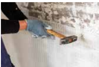
Enfoncer les chevilles jusqu'à ce qu'elles soient encastrées dans l'excroissance
