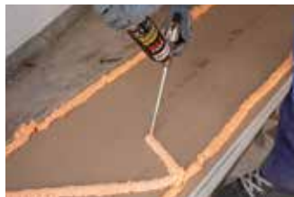
Gipskarton inlijmen met Rectavit Easy Fix
