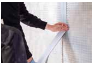
Plaats DryStone Tape op de naden, hoeken, beschadigingen, rond inbouwdozen, leidingen,...
