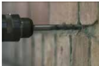
Boor elke 10-12cm gaten van 12mm door 90% van de muur
