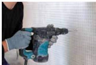
Boor om de 25cm gaten in het midden van de nop
