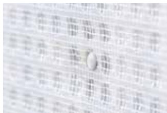
Het membraan tussen 2 pluggen steeds strak trekken
