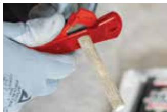
Snij de Stick op maat (= boordiepte - 0,5cm)
