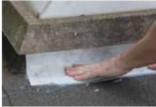
DryStone Textile in een tweede dunne laag duwen
