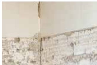
Verwijder plinten en pleisterwerk
