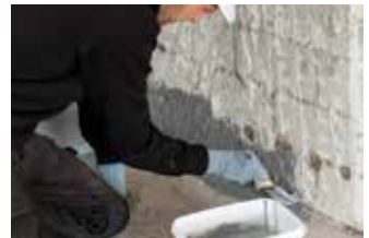
Werk tot +/- 5cm boven de boorgaten
