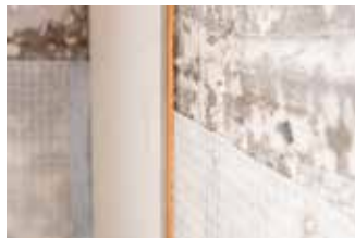
De plaat op zijn plaats zetten en goed aandrukken
