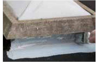
Min. 4 cm rond het vlies een laatste dikke laag aanbrengen
