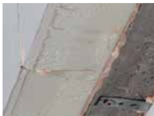
Isolation intérieure en carton-plâtre
