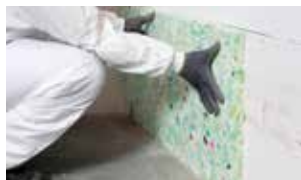
3. Placer contre le support et maintenir pendant 1 min.
