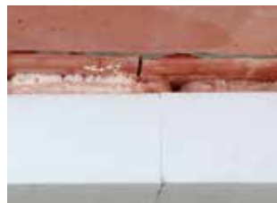
6. S'assurer que le contact avec le support est suffisant.
