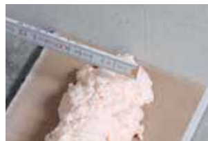
Cordon de colle Ø min. 5 cm Aplanir les irrégularités (max. 2 cm)
