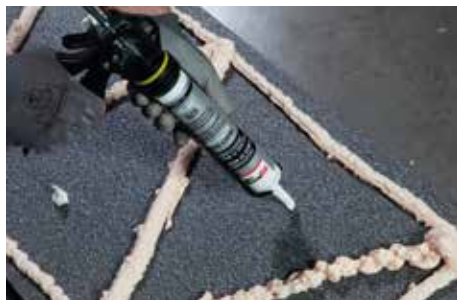
2. Placer des points de colle de montage à haute adhérence initiale entre les cordons.
