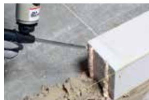
6. Les blocs d'assise peuvent être jointoyés verticalement
