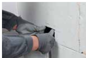
3. Positionner le boîtier électrique dans la masse de colle
