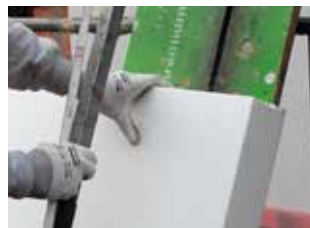
3. Découper le panneau à la mesure exacte.
