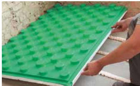
2. Positionner un panneau sur la couche de colle.
