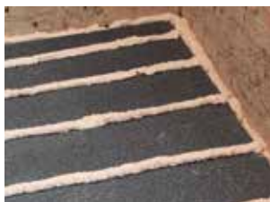
Isolation du plancher des combles
