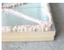
Collage de panneaux d'isolation
