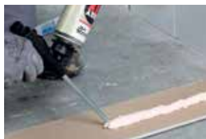
6. Ouvrir le pistolet et encoller le panneau
