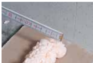
Cordon de colle Ø 3 à 4 cm Aplanir les irrégularités (max. 1 cm)
