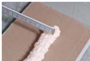
Cordon de colle Ø 1 à 2 cm Collage face contre face
