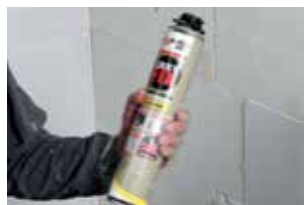
1. Agiter vigoureusement la mousse adhésive NBS 30 fois ou pendant 30 s.
