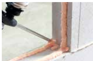
10. Encoller aussi les joints verticaux
