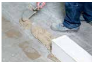
5. Travailler en suivant un cordeau de maçon
