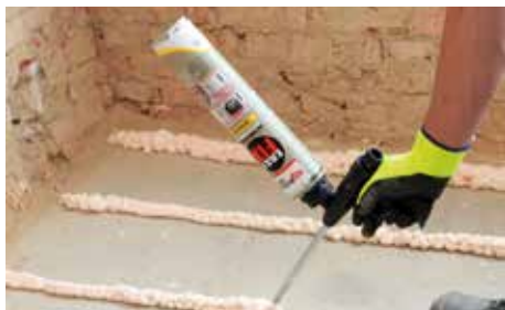
1. Appliquer Easy Fix sur le support.
