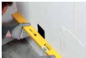
4. Maintenir le boîtier électrique en place pendant 30 s
