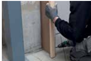
5. Visser une poutre à gauche du panneau
