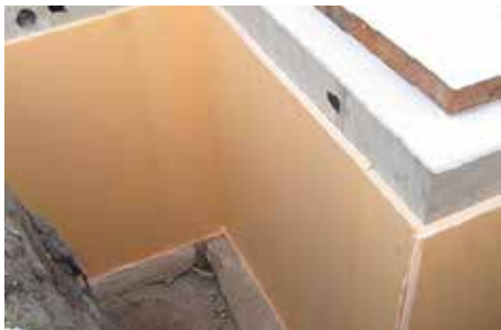
5. Effectuer la finition des angles de raccordement.
