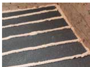
4. Encoller les panneaux d'isolation.
