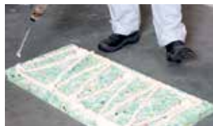
1. Encoller le panneau avec Easy Fix.
