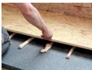
5. Placer le sous-plancher perpendiculairement aux panneaux d'isolation.
