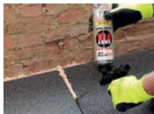
3. Comblers les joints et les interstices.
