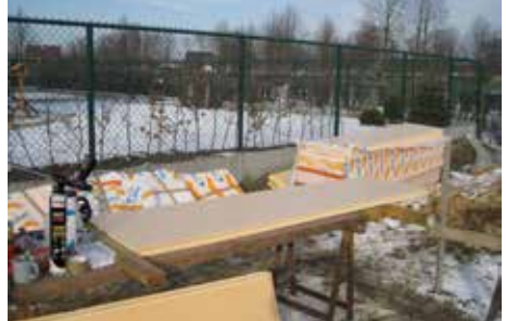
2. Encoller les panneaux.
