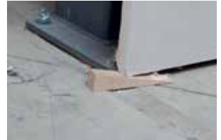
9. Soutenir le panneau de finition d'extrémité
