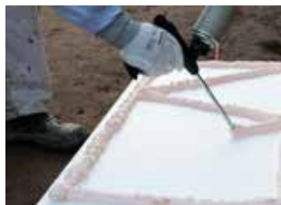
4. Appliquer Easy Fix sur le panneau et attendre environ 5 min.
