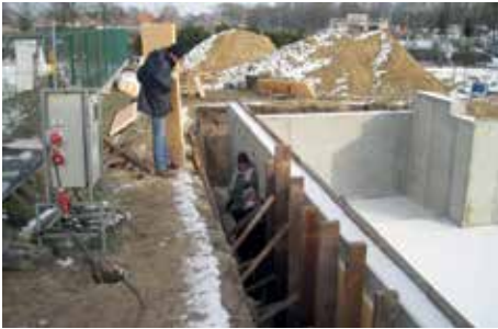
3. Positionner les panneaux.
