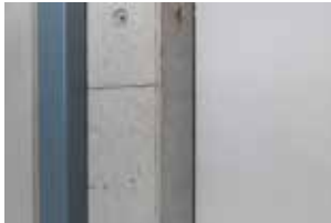
1. Parachever les cloisons à gauche et à droite du poteau
