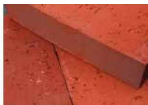
Pierre, béton, maçonnerie,...
