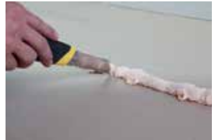
6. La colle peut être coupée. • Easy Fix : après 25 min • Easy Fix Turbo : après 15 min
